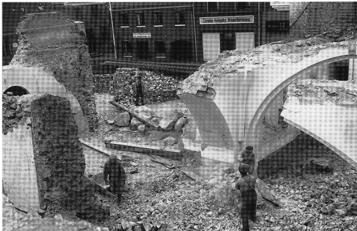
Fig. 22. Kirken under ombygningen 1933, set mod sydvest. Skibets hvælv er under nedbrydning. Af søndre korsarm ses kun sydturen. M. Rasmussen fot. - Die Kirche während des Umbaus 1933, gegen Südwesten. Das Schiffsgewölbe beim Abriß. Vom südlichen Kreuzflügel ist nun die Südmauer sichtbar.
