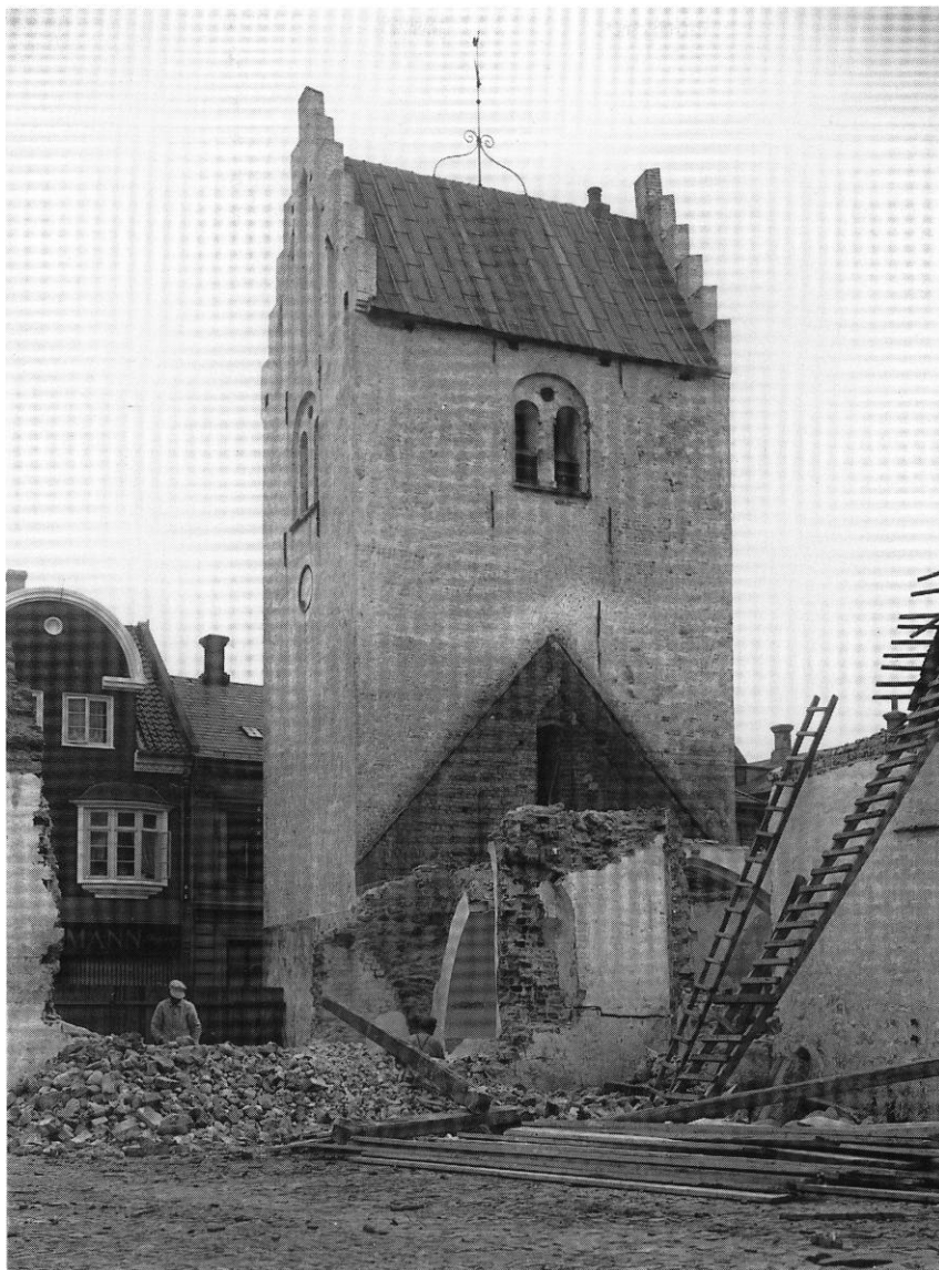
Fig. 32. Kirken set fra sydøst under ombygningen 1933. Skibet og søndre korsarm er under nedbrydning. M. Rasmussen fot. - Die Kirche von Südosten während des Umbaus 1933. Schiff und südlicher Kreuzflügel beim Abriss.
