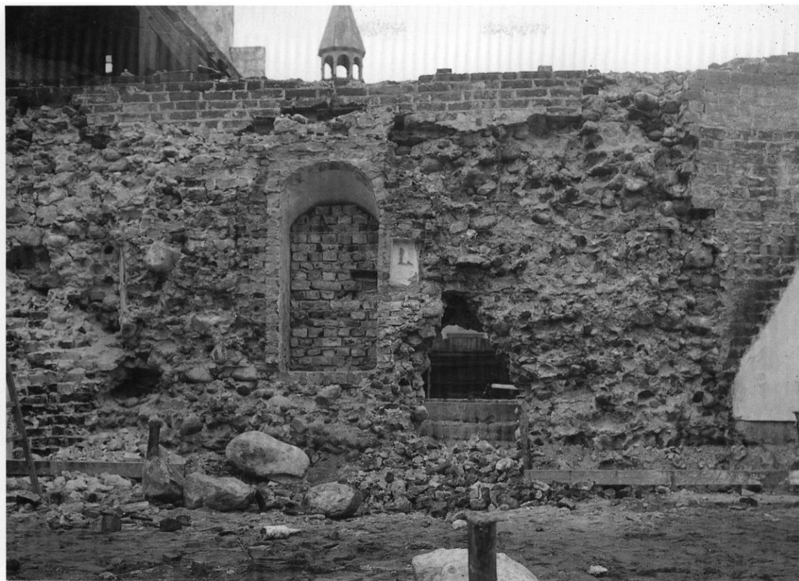
Fig. 13. Skibets nordvæg, afsnittet øst for korsarmen, afbanket for puds under kirkens ombygning (s. 340). I midten tilmuret pulpitudør (s. 377). M. Rasmussen fot. 1933. - Nördliche Schiffswand, Abschnitt östlich des Kreuzflügels, Putz beim Kirchenumbau abgeklopft. In der Mitte zugemauerte Emporentür. Aufnahme 1933.
