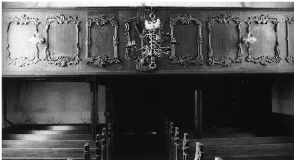
Fig. 56. Søndre korsarm o. 1930 med lysekrone nr. 2 (s. 386) og ↑pulpitur nr. 6 (s. 381), opført 1889 som orgelpulpitur med genbrugt rokokopanel og altertavlens topfigur (jfr. fig. 36) fæstnet midt på brystningen. Hother Paludan fot. - Südlicher Kreuzflügel um 1930 mit Kronleuchter Nr. 2 und ↑Empore Nr. 6, errichtet 1889 als Orgelpulpore mit wiederverwendetem Rokokopaneel und Spitzenfigur vom Altarbild (vgl. Abb. 36).
